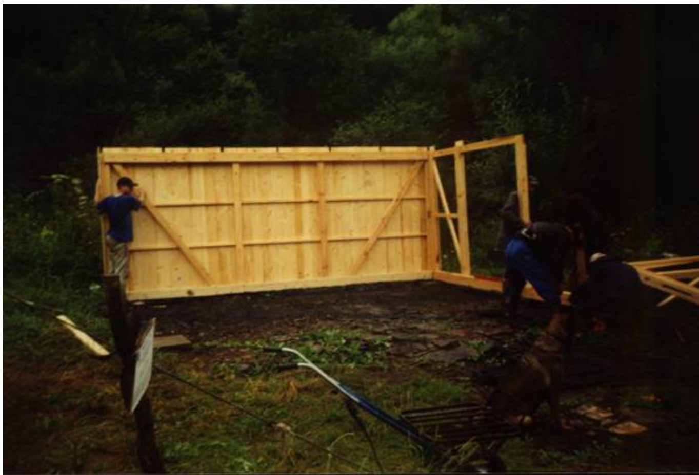
Rozpoczęcie budowy nowej wiaty – sierpień 2002r.
